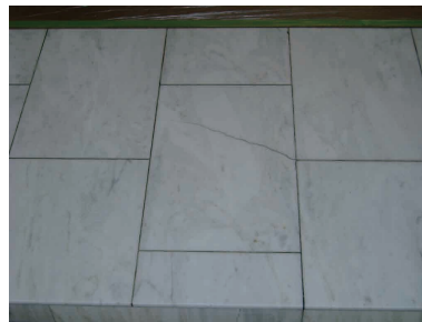
上の写真の個所の傷んだ保護剤を除去した後です保護剤塗布前です
