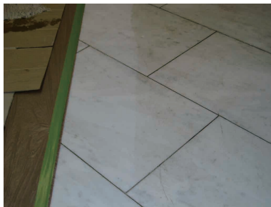
カーペットの際は機械洗浄だと染み込む恐れがあるので手作業でおこないました
